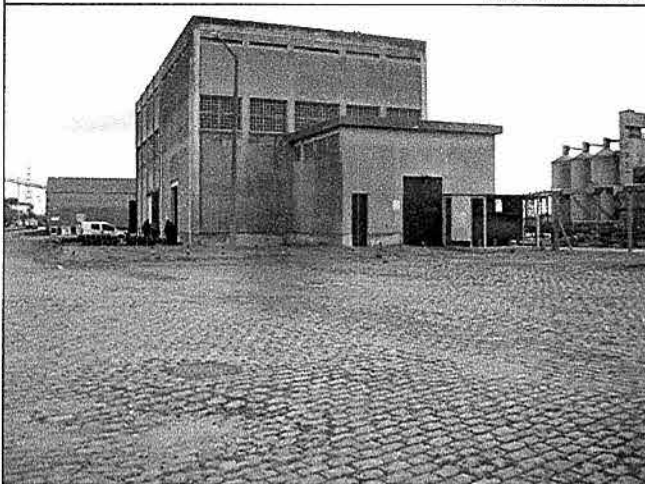
Sala de Bombas Toma de Agua - CTC
