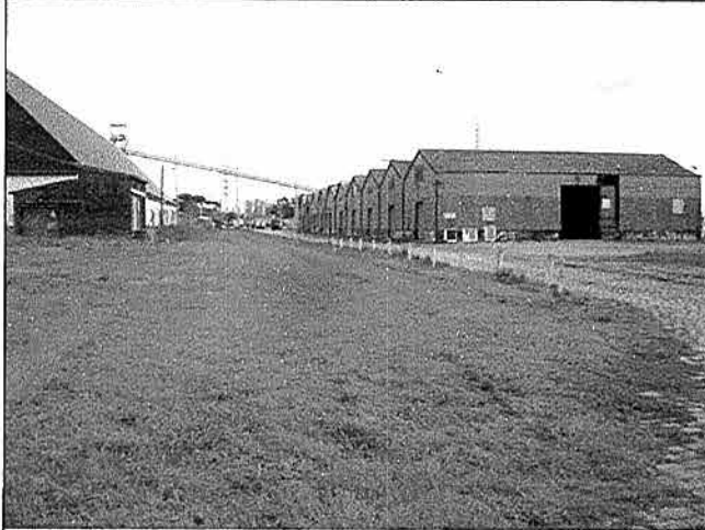
Galpones de Demoler
