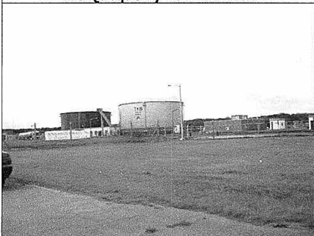
Tanques de Combustible - CTC
