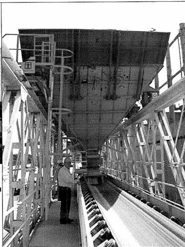
Vista de una instalación de descarga similar a la que prevé Pier Doce, compuesta por una cinta transportadora y tolva móvil, emplazada en el Río Paraná
