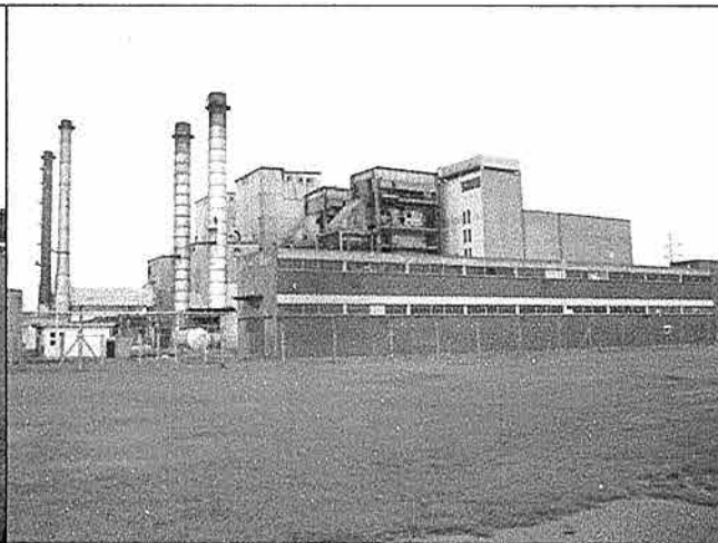
Central Termoelectrica de la Costa (CTC)
